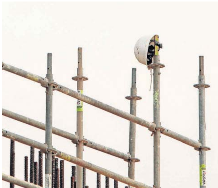
Obras de construcción en Valencia, paralizadas por el estado de alarma.
