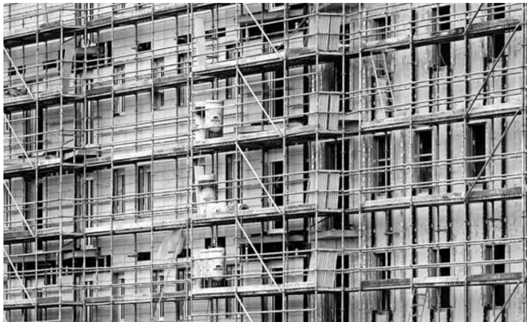
Obra de construcción de un edificio residencial afectada por el parón de las dos últimas semanas.
